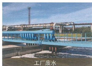
工厂废水 监测终端排水
